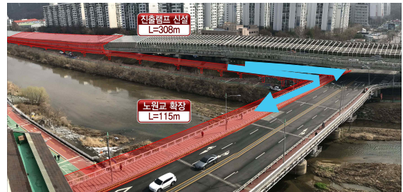
〈동부간선도로 확장(노원교 진출램프)〉
