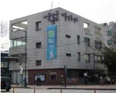
리모델링 공사 전
