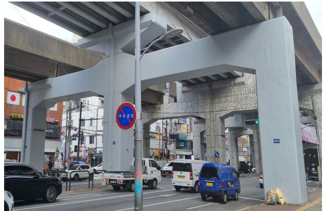
< 탄산화 보수 후 >
