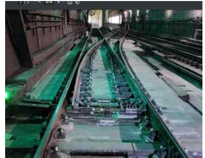
〈 콘크리트 분기기 개량 〉
