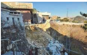
[붕괴구간 공사] ▲인왕곡성
