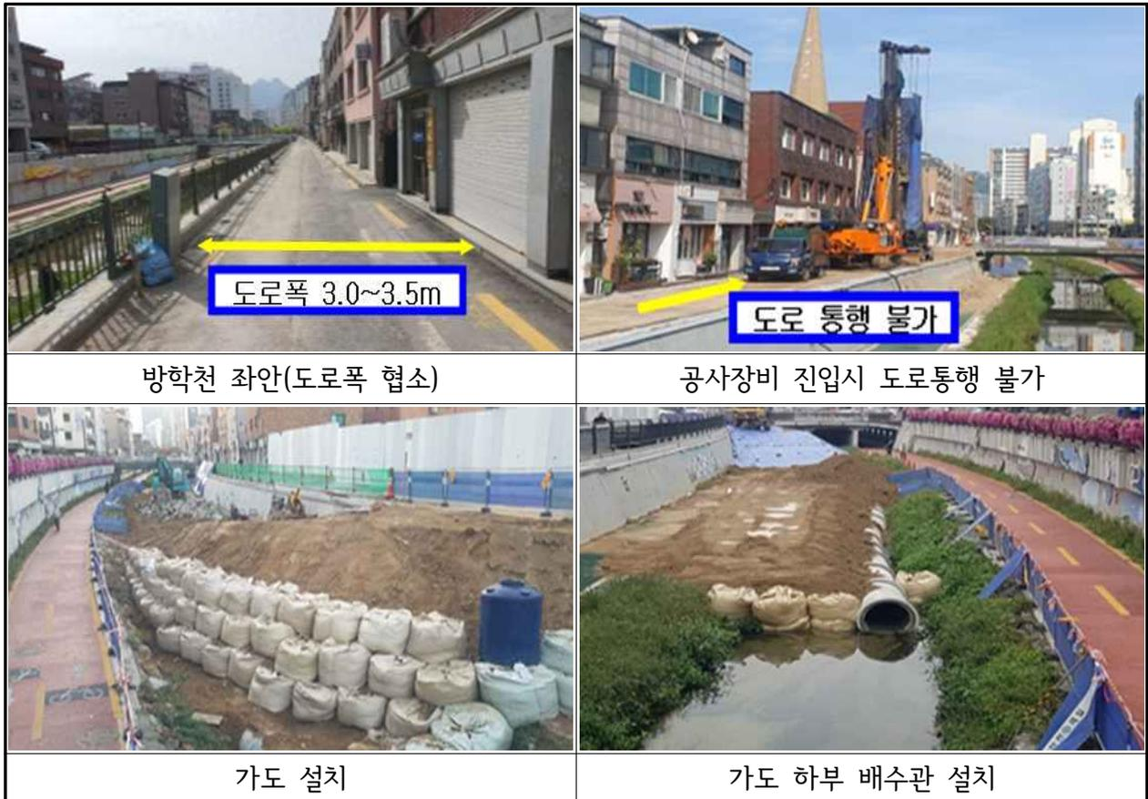
[그림] 방학천(도봉구) 좌안 제방 상부도로 및 가도, 하부 배수관 설치 현황
