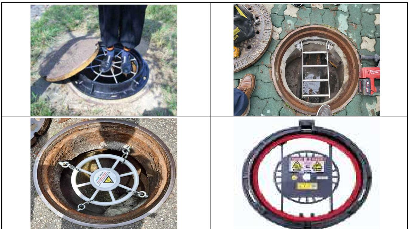
[그림] 맨홀 추락방지시설 종류 및 설치 사진
