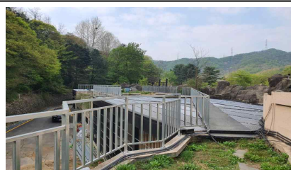
안전 난간 설치
