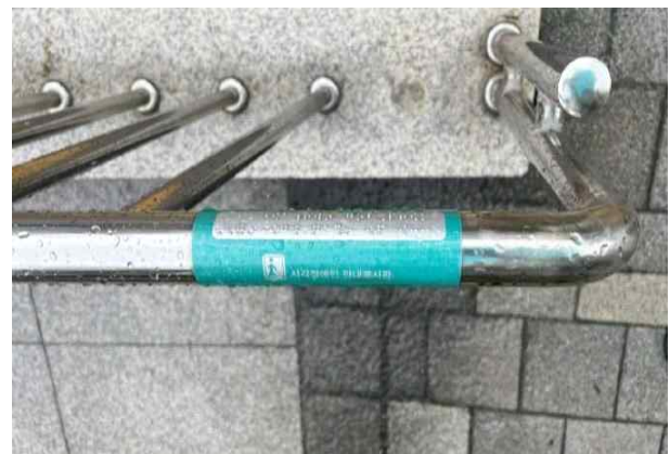
< 계단 핸드레일 역방향 부착 재시공 >
