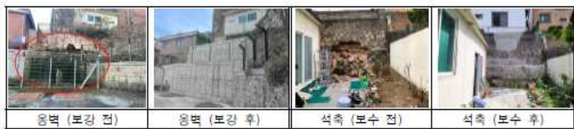
<옹벽 및 석축 보수 지원(지역건축안전센터)>
