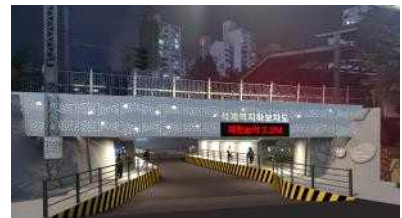
석계역 지하보차도로 공간개선사업
