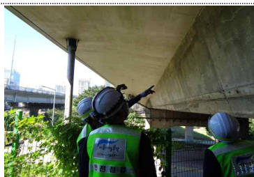
〈 교량 바닥판 점검 〉
