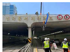
〈침수부 수중펌프 설치〉
