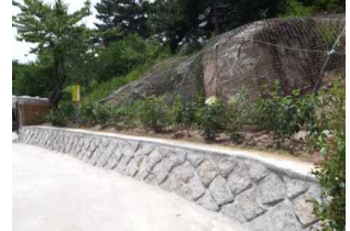
< 낙석망 등 설치 >
