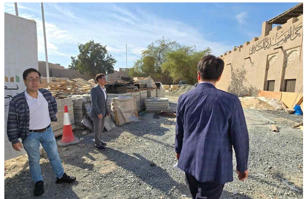
⑧ 두바이 수해피해 복구지역 시찰중 1
