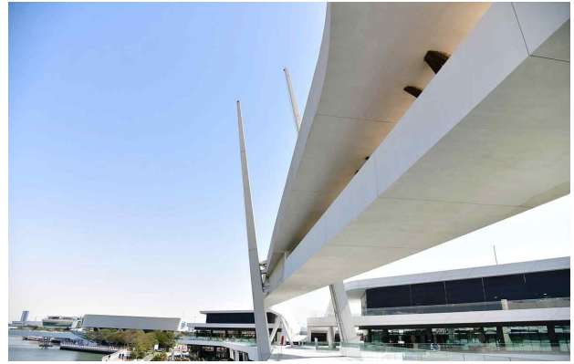
④ 알카나 1번 보행교 상부 전경
