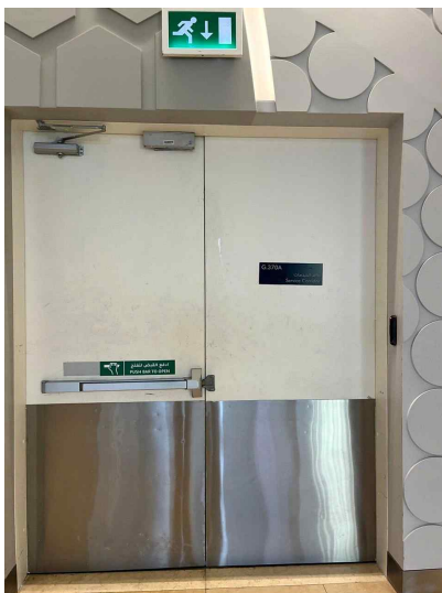
④ 다중이용시설(야스몰) 비상구
