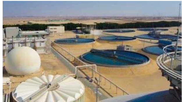
② TAQA Water Solutions 하수처리시설장 전경 (출처 : TAQA Water Solutions)
