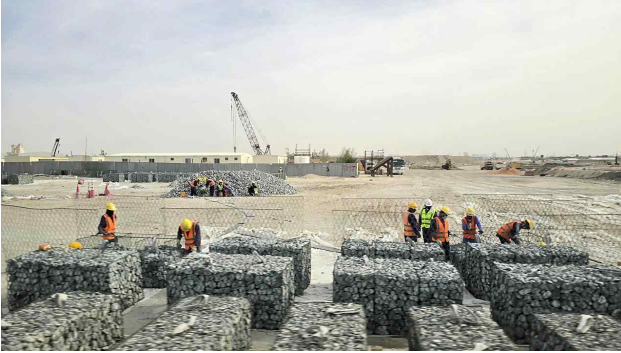
① 쌍용건설 두바이 Creek Waters 프로젝트 개발 현장
